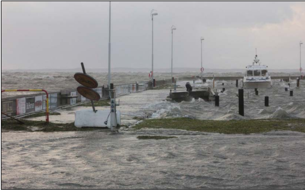
Översvämning av hamnplan och södra piren överspolas under Adventsstormen (2011-11-27).
