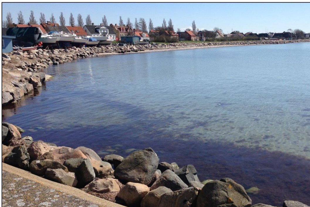
Figur 4-6 Södra pirens anslutning mot land och stranden med stenskonig söder om hamnen. Vinteruppställda båtar på land.
