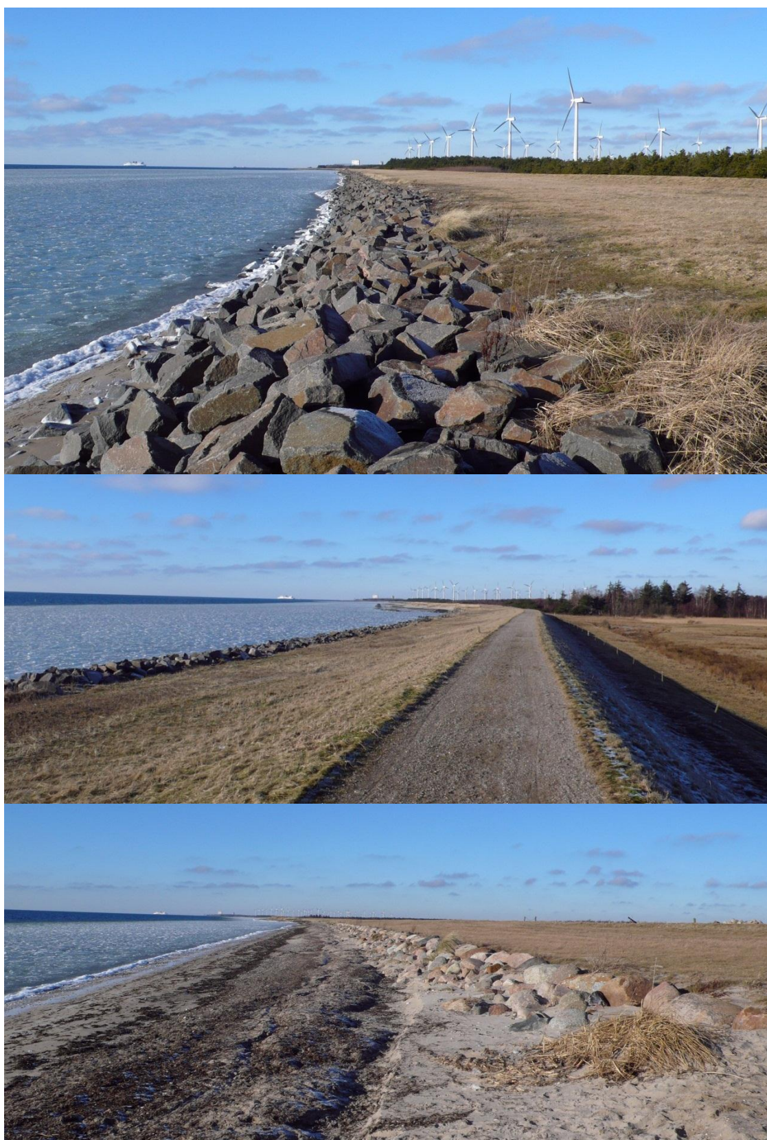
Figur C-3 Exempel på strandskoning av sten som skyddar foten av en strandvall på Lolland, Danmark.
