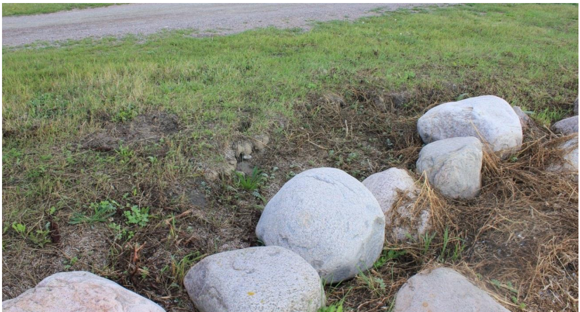
Figur 4-17 Foto av den skyddade sträckan söder om Borstahusens hamn där man ser hur marken skadats ovanför stenskoningen (sträcka 7).
