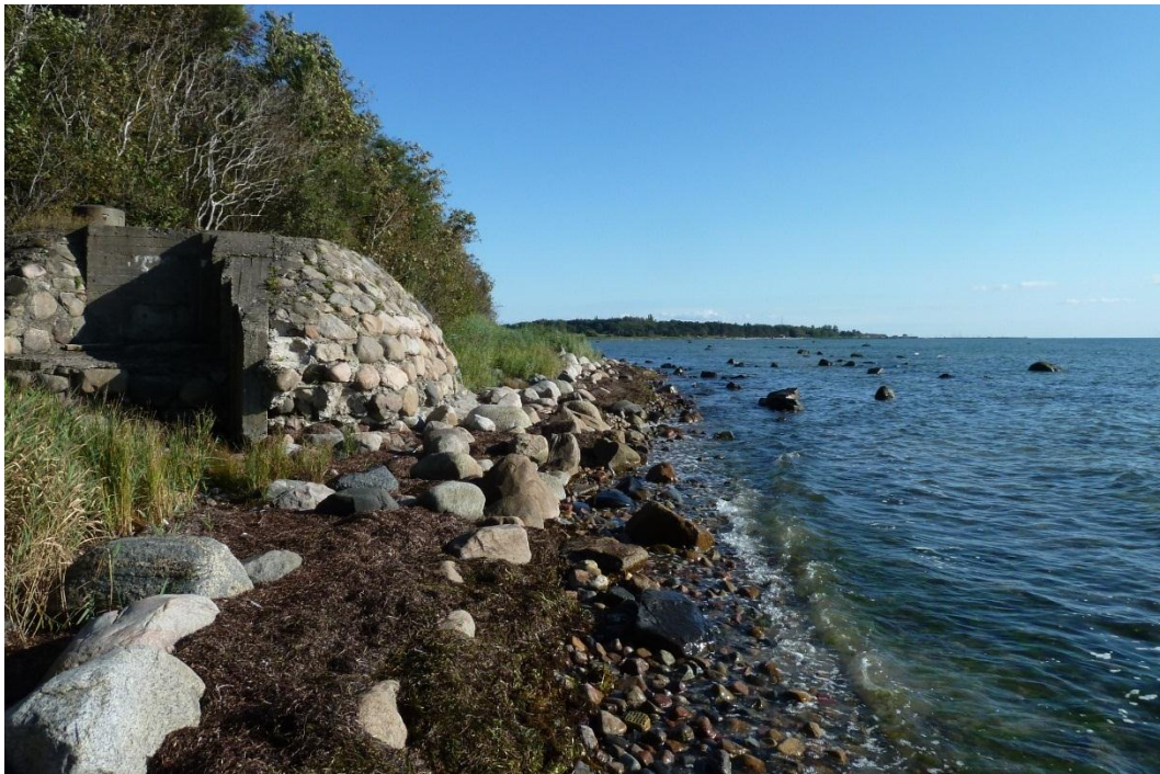
Figur 4-4 Foto av kusten utanför Hildesborg mot söder. Låg stenskoning delvis övertäckt med uppspolad tång. Viss erosion kan ses.
