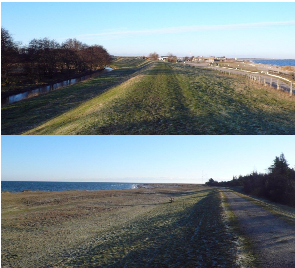
Figur C-1 Exempel på vallar som placerats ovanför en naturlig strandäng på ön Fehmern i Tyskland.
