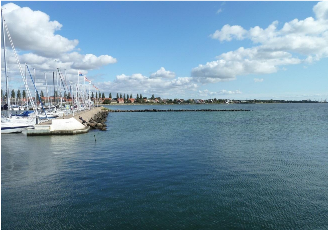
Figur 4-16 Foto av öppningen in till Borstahusens hamn, notera den utstickande vågbrytaren från den södra piren och sandackumulationen som byggs på från sydväst fram till en bit in i öppningen och som markerats med en pinne en bit utanför pirens slut.
