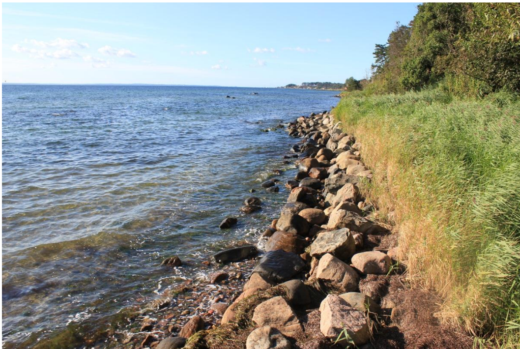
Figur 4-3 Foto av kusten utanför Hildesborg mot norr. Låg stenskoning som delvis är övertäckt av uppspolad tång som i sin tur har blivit överväxt av vass.
