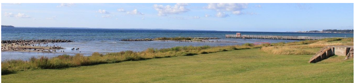
Figur 4-11 Foto av utfyllnadsområdet utanför nuvarande campingen med de tre vågbrytarna och en badbrygga.
