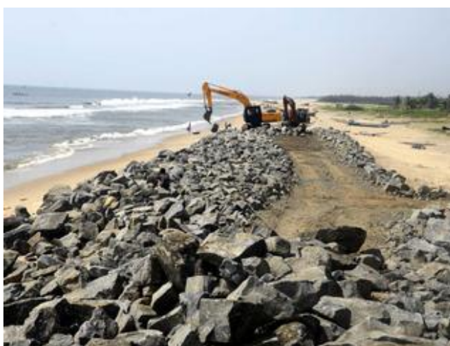
Figur C-2 Exempel på en strandskoning av sprängsten under konstruktion.
