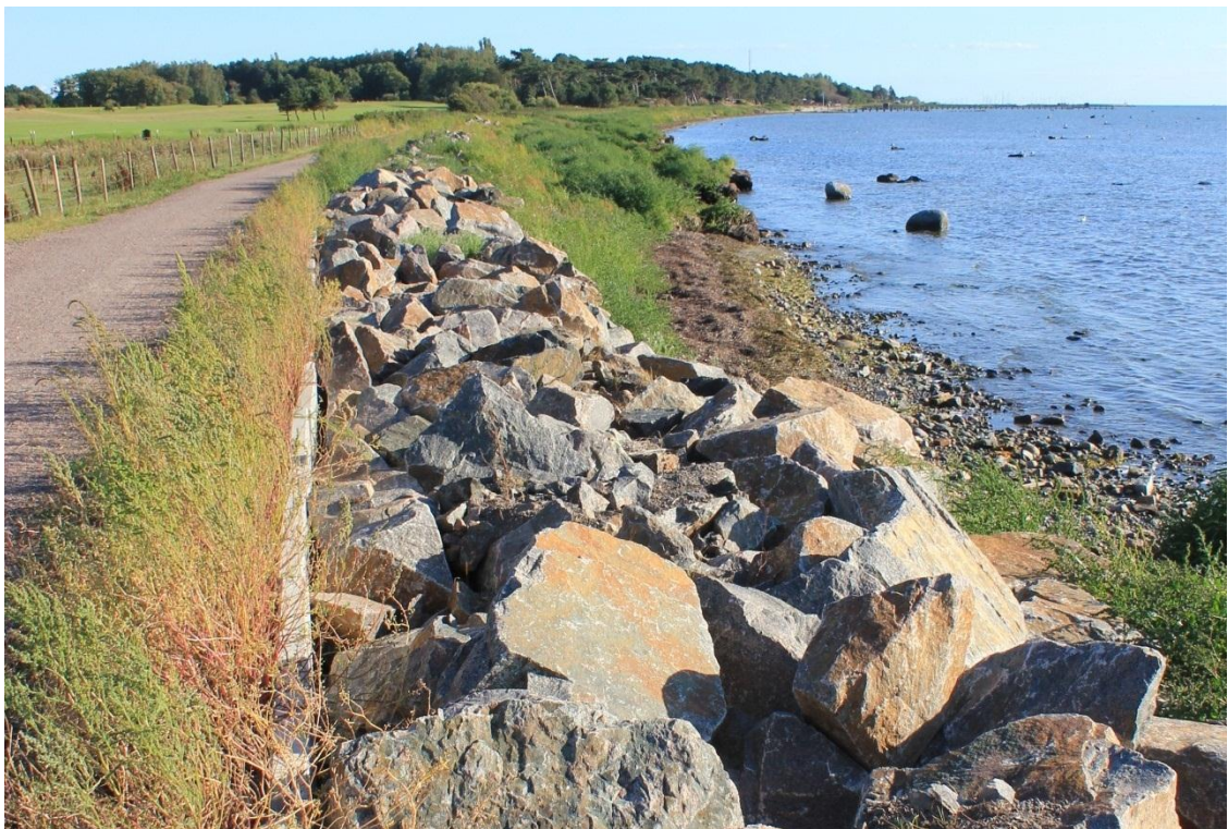
Figur 4-5 Foto av kusten vid den södra delen av sträcka 1 som visar den nykonstruerade betongväggen och stenskoningen av sprängsten. Kustens naturliga utseende ses i bakgrunden.
